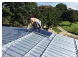
太阳能板安装
