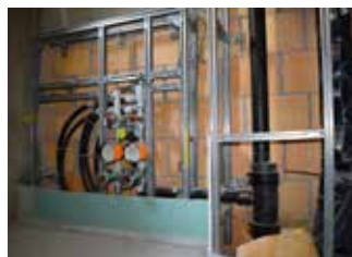
电器&管道安装
