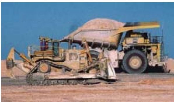
徕卡推土机 2000T 系统利用实时 GPS 对地面坡度进行导向和检验
